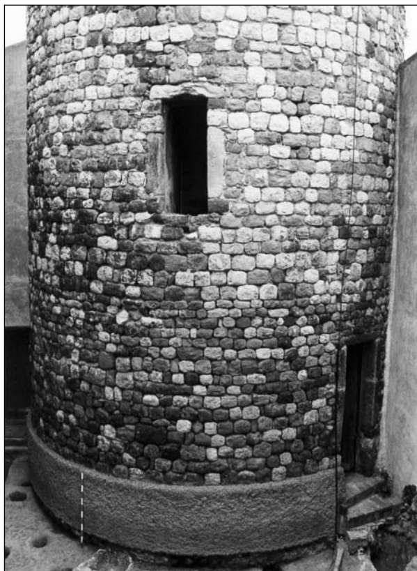
Vista de la part inferior de la torre (s. XII) situada al centre de l'edifici. S'observa la finestra oberta en el primer pis, la porta d'accés actual i la seva fonamentació descalçada (en el moment de la fotografia, tapada per una potent capa de ciment).
